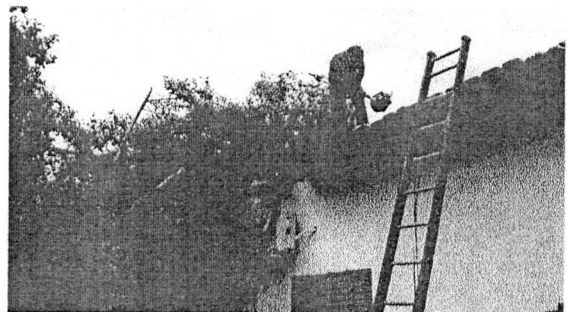
DETALHE: SERVIÇO DE RETIRADA DE GALHOS PESADOS DO TELHADO.
